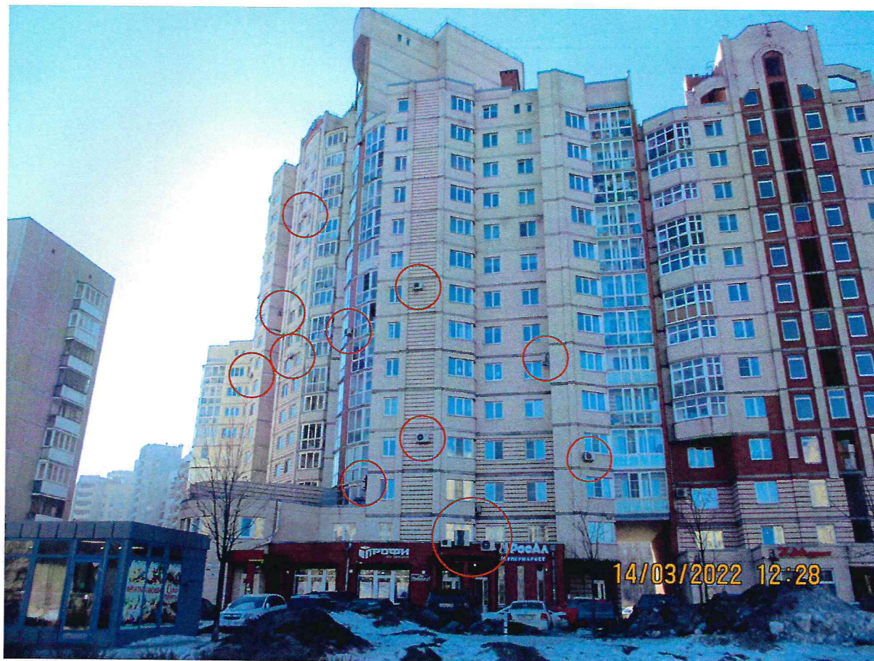
Обзорная фотография фасада здания. Инженерное и техническое оборудование – наружные блоки систем кондиционирования и вентиляции.
