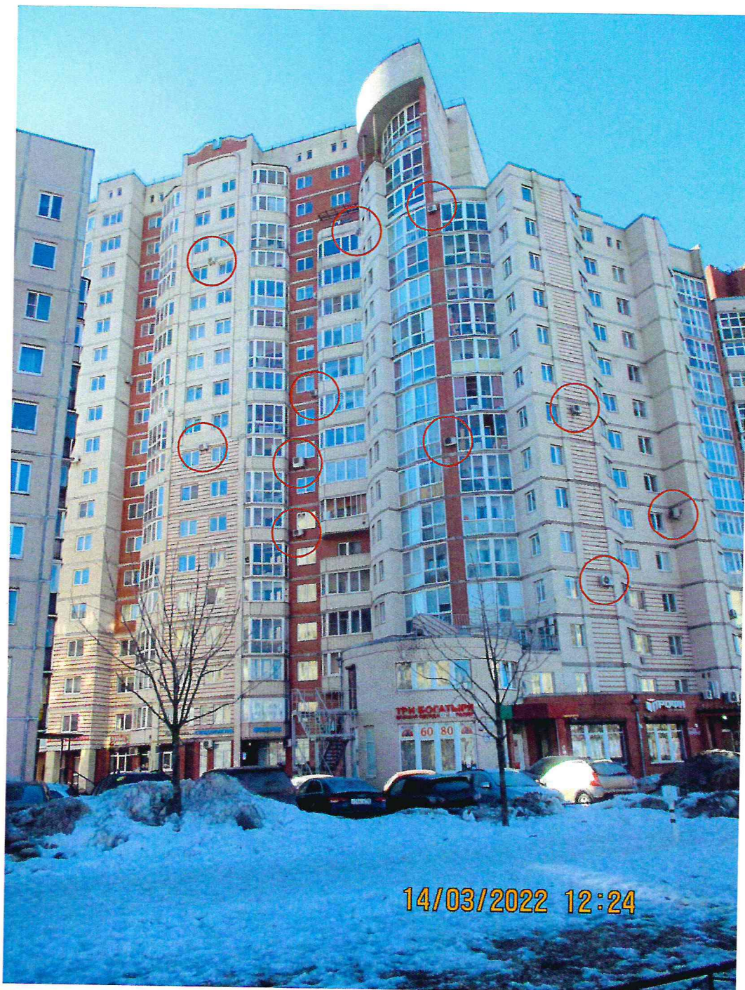
Обзорная фотография фасада здания. Инженерное и техническое оборудование – наружные блоки систем кондиционирования и вентиляции.
