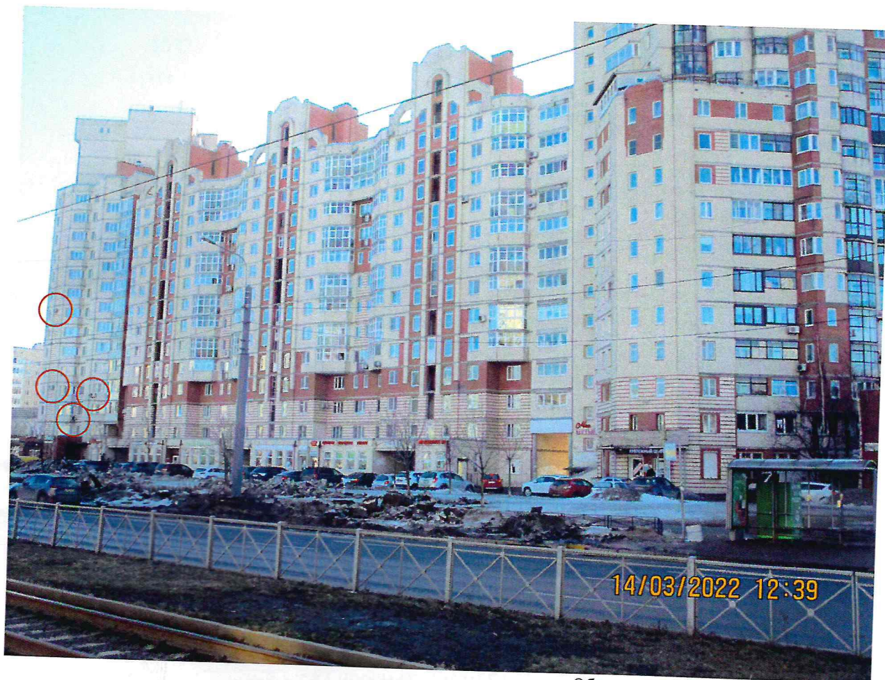
Обзорная фотография фасада здания. Инженерное и техническое оборудование – наружные блоки систем кондиционирования и вентиляции.
